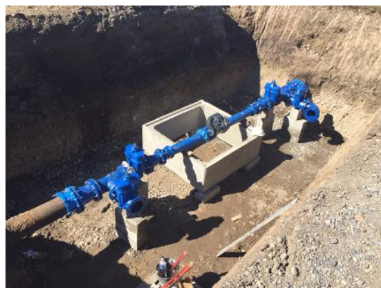
Pose d'un débitmètre
